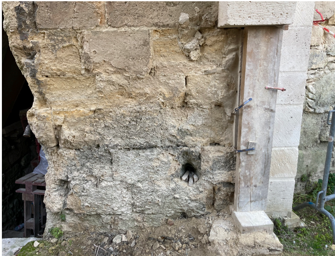
Porte à pont-levis - mur ouest
