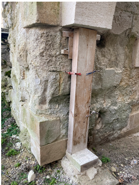
Porte à pont-levis - Piédroit et jambage est
