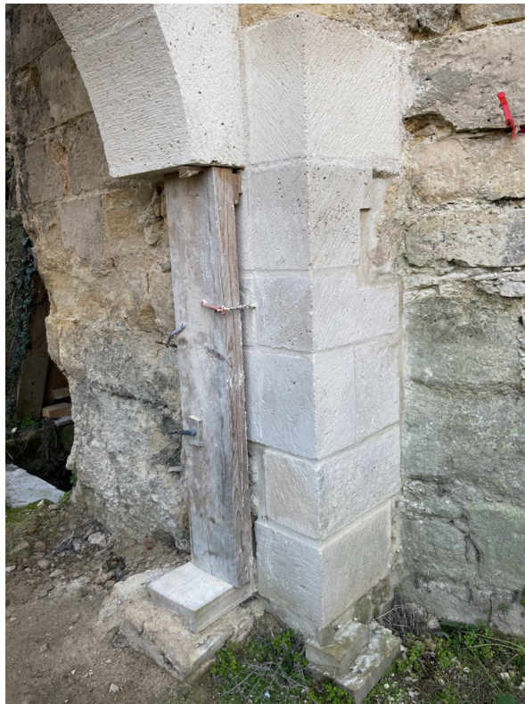
Porte à pont-levis - Piédroit et jambage ouest
